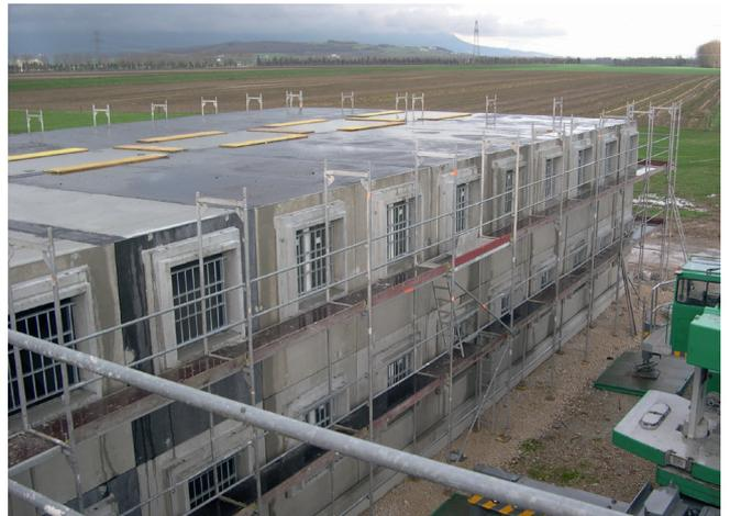
Die Betonmodule werden mittels Speziallagern aufeinandergestellt und für Erdbebenlasten gemäss SIA-Norm kraftschlüssig gesichert.
