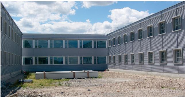
Da ein grosser Anteil der Arbeiten im Vorfabrikationswerk ausgeführt wird verkürzt sich die effektive Bauzeit um ein Vielfaches, was insbesondere bei späteren Erweiterungen bestehender Anlagen bezüglich Überwachung und Sicherheit von grossem Vorteil ist.
