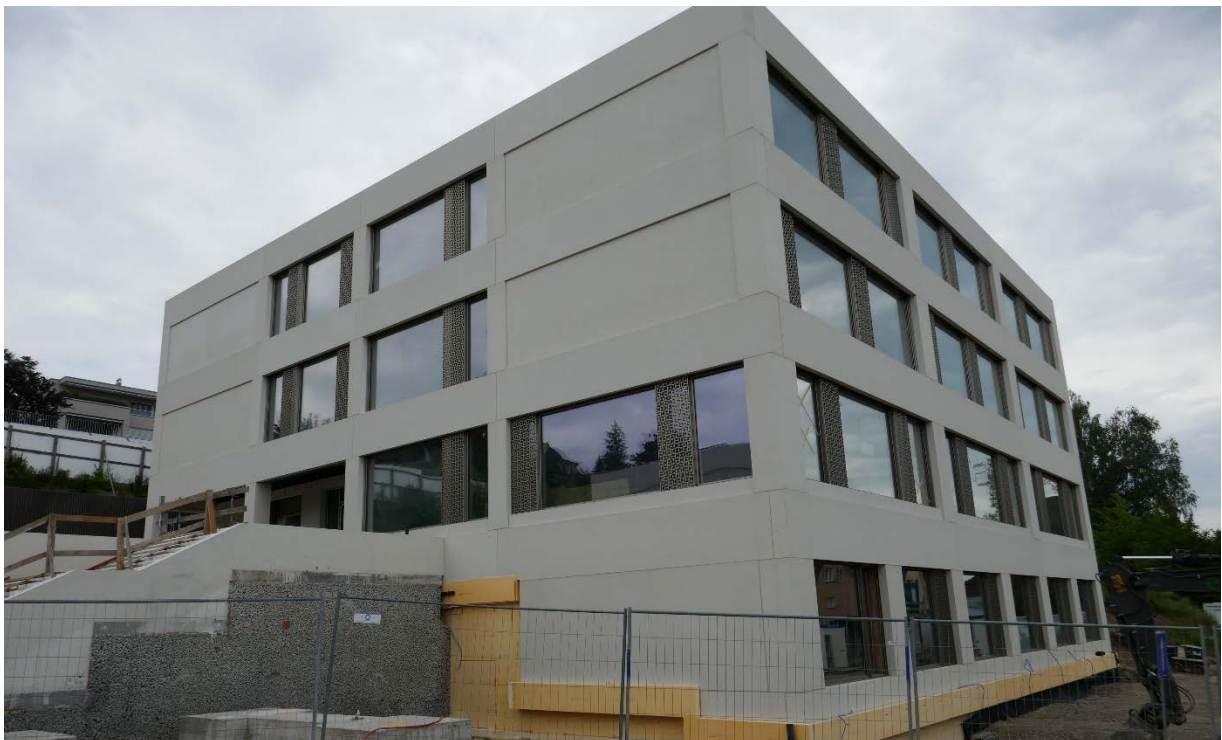
Schulanlage Goldbach, Küsnacht
