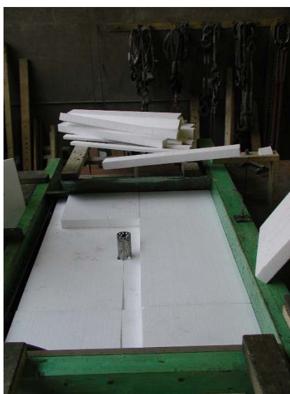
Double couche d'isolation thermique avec ancrage à manchette au milieu
