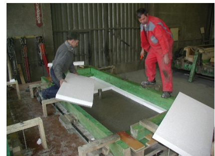
2. Pose couche d'isolation thermique
