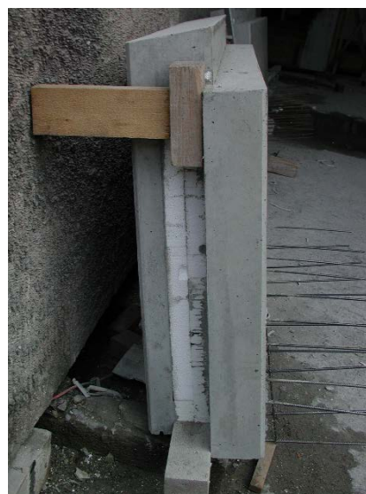
Structure des panneaux sandwich
