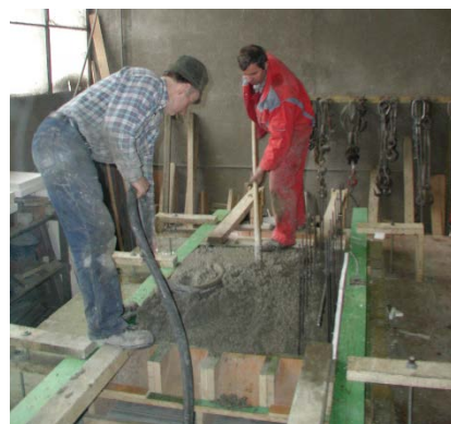
3. Remplissage couche porteuse
