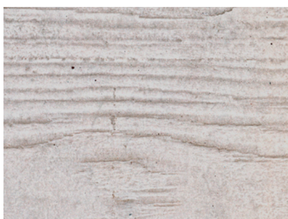
Beton Grau Brettstruktur
