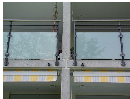
fixation par ancrages adhésifs
