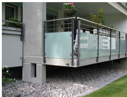
drainage par gargouille
