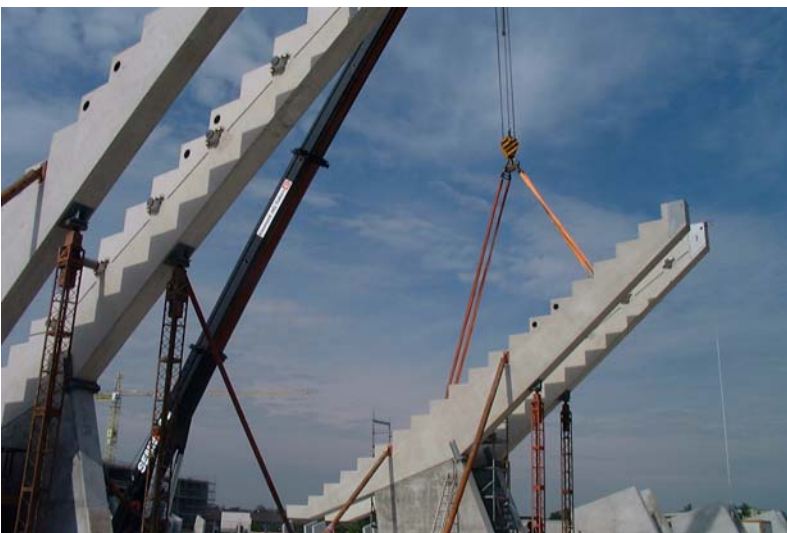
Montage des crémaillères supérieures
