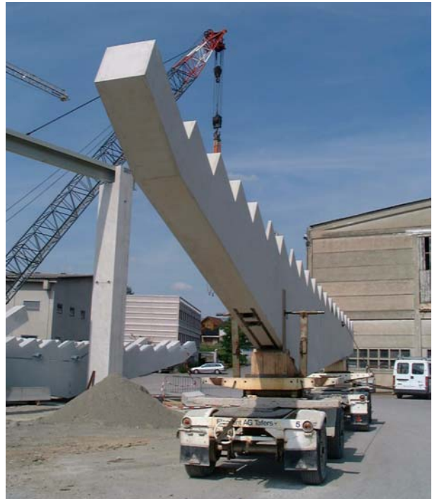
Transport sur la place de stockage
