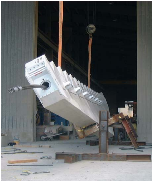
Les crémaillères sont tournées après le décoffrage
