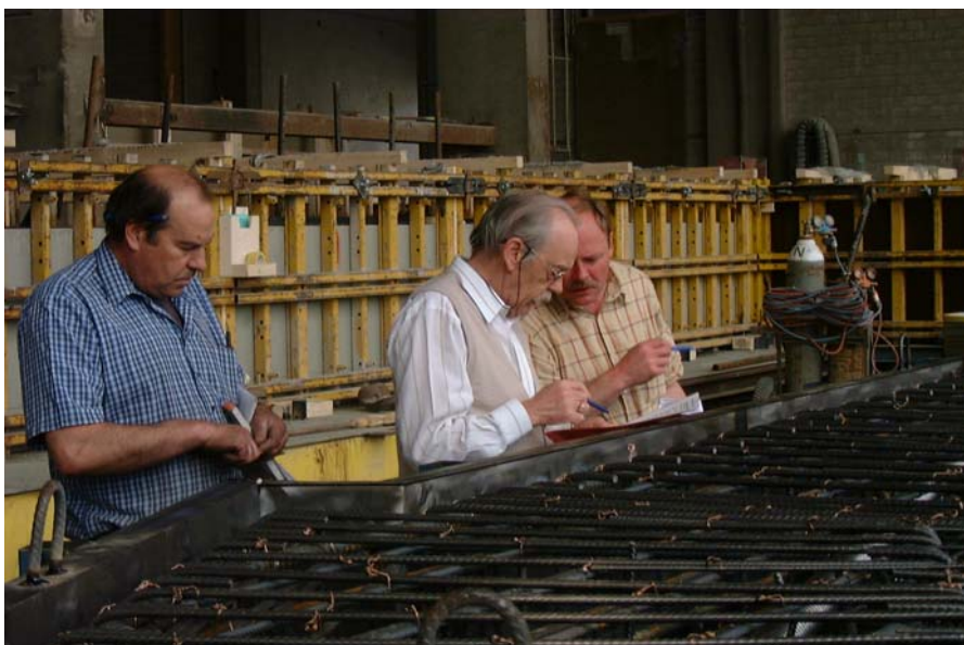
23.04.2003 Dernier contrôle avant le bétonnage
