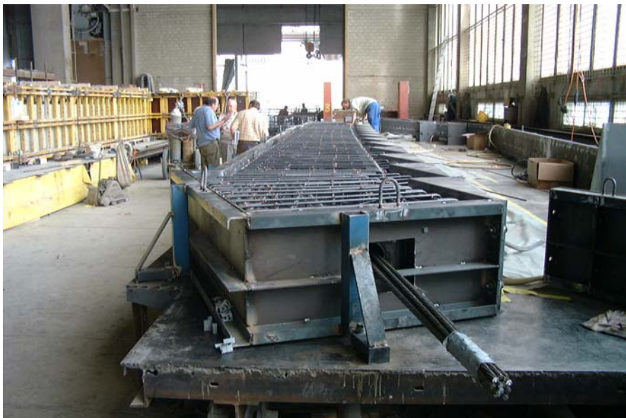
23.04.2003 La première armature est posée
