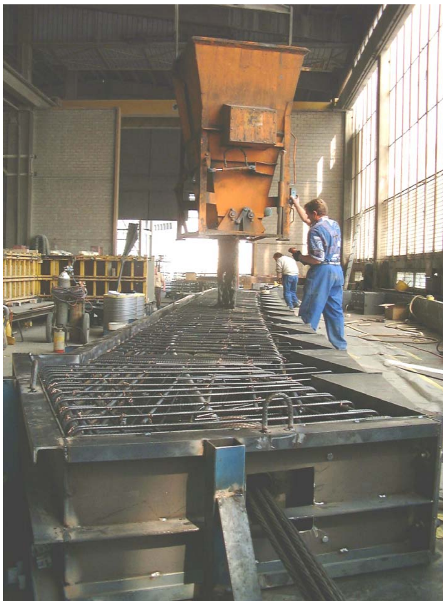
23.04.2003 Bétonnage du premier sommier à crémaillères
