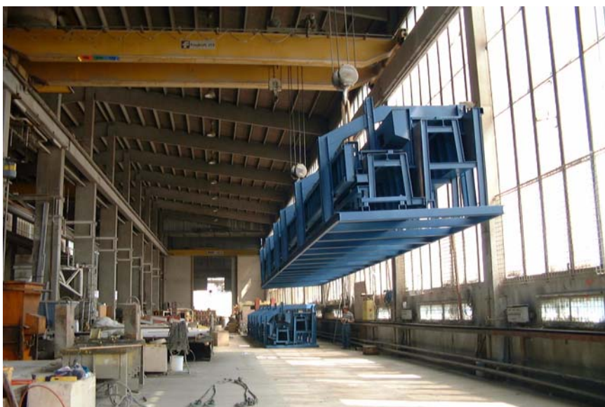
Installation des coffrages métalliques pour les gradins supérieurs
