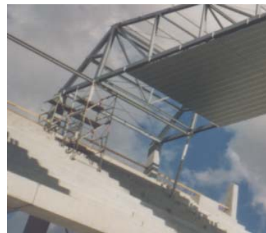
Liaison de la tribune avec la toiture
