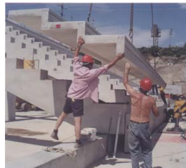
Montage des gradins
