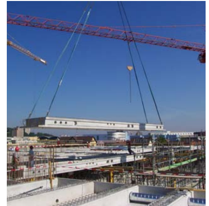
Montage avec grue sur pneus de 200t
