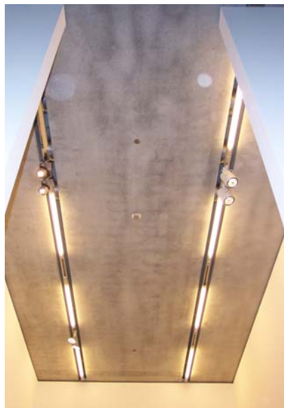
Face inférieure du plafond fini avec éclairage
