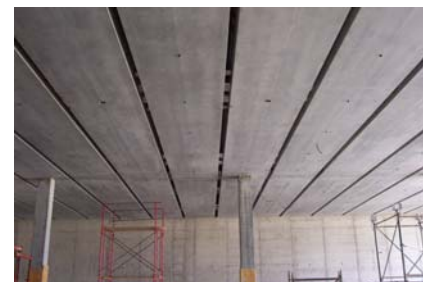
Face inférieure du plafond dans le gros oeuvre
