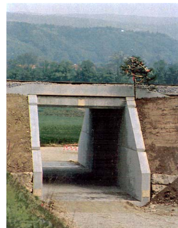
Passage inférieur « Bedmen » après le montage
