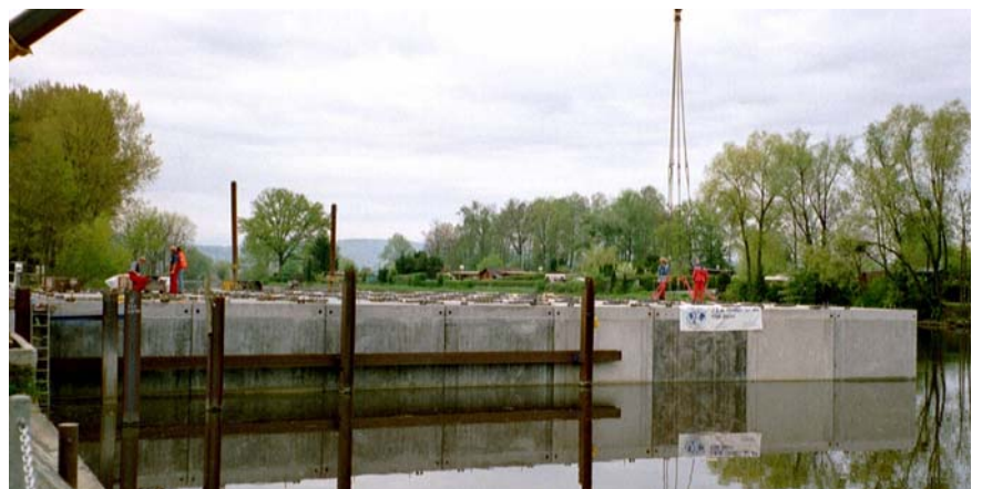
Assemblage des cubes à la plate-forme submergée dans le canal de la Broye
