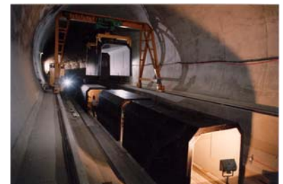
Montage dans le tunnel de Habsbourg
