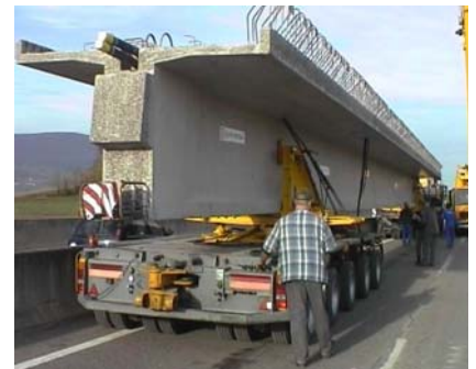
Prêt au montage
