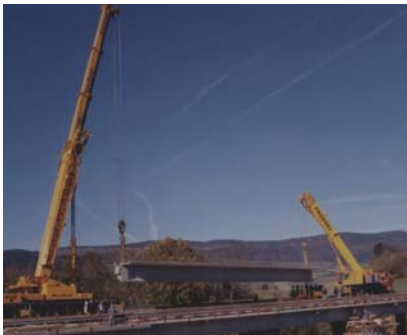
Montage avec 2 grues sur pneus
