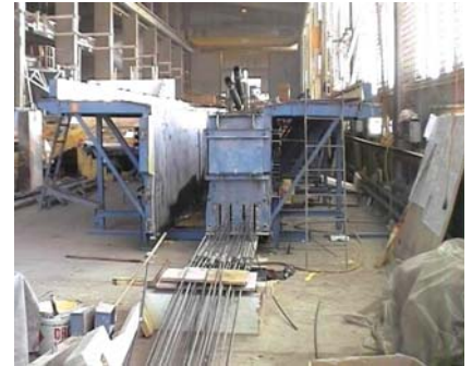
Coffrage et lits de torons précontraints
