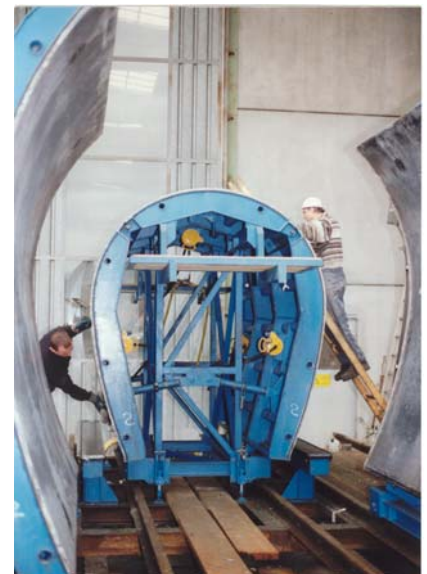
Coffrage métallique pour la production
