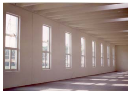
Vue intérieure de la halle
