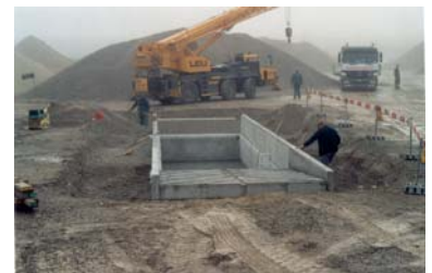
Cuve terminée avec la dalle de transition
