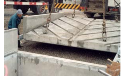
Montage de la dalle de transition
