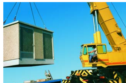
Montage d'une station au moyen d'une grue sur pneus
