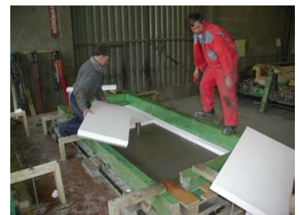
2. Pose de la couche d'isolation thermique
