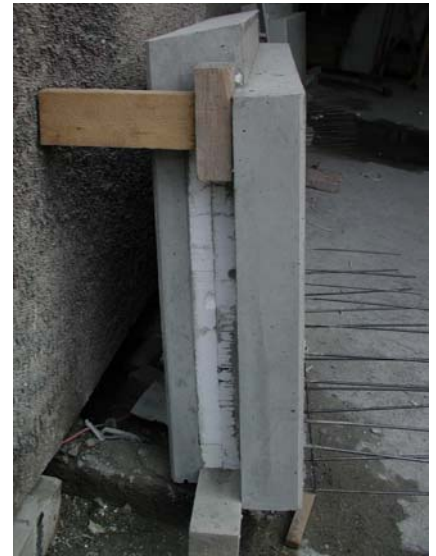
Structure des panneaux sandwich
