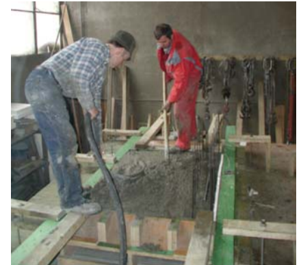
3. Remplissage de la couche porteuse
