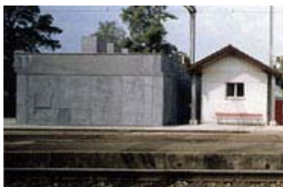
Bâtiment normalisé des chemins de fer (NGB) Bienne-Mâche
