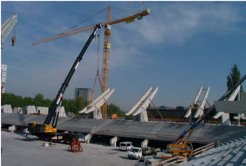
Die untere Tribüne ist grösstenteils montiert.
