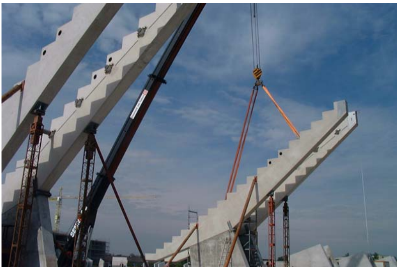
Montage der oberen Sägeträger
