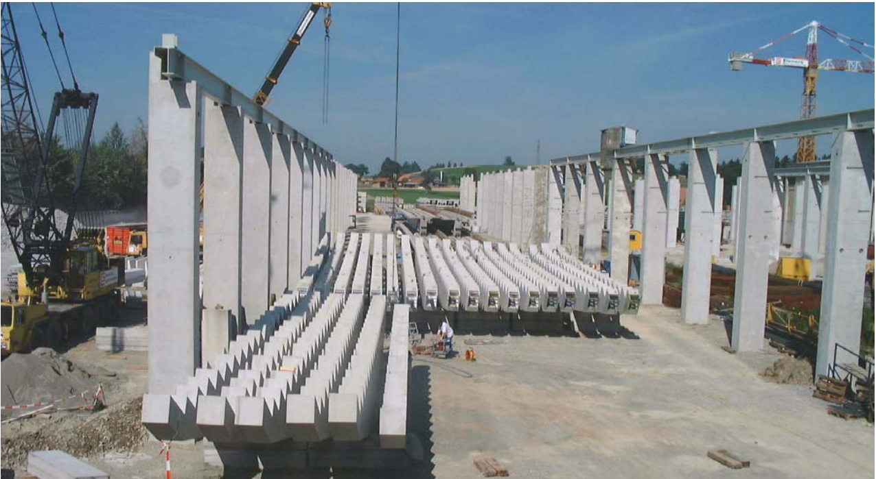
Die Sägerträger sind bereit zum Vorspannen
