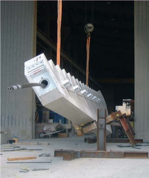
Drehen der Sägerträgers nach dem Ausschalen
