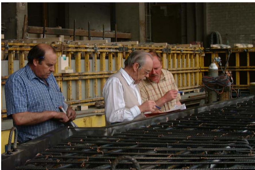
23.04.2003 Letzte Kontrolle vor dem Betonieren
