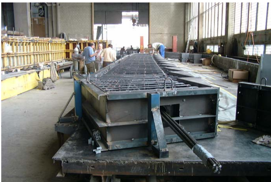
23.04.2003 Die erste Armierung ist verlegt
