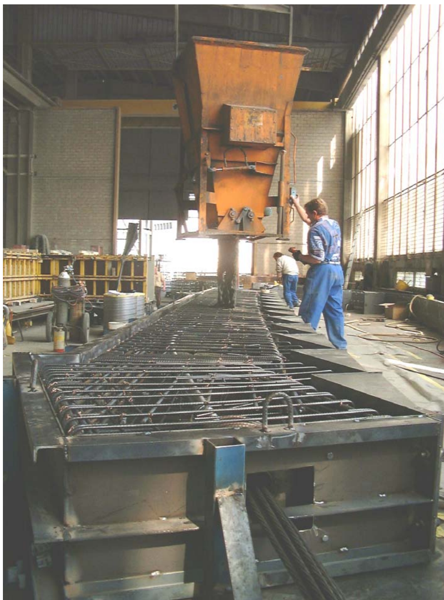
23.04.2003 Der erste Sägeräger wird betoniert
