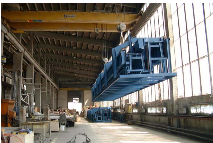
Die Stahlschalungen für die oberen Tribünen werden eingerichtet
