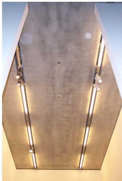
Untersicht Decke fertig mit integrierter Beleuchtung
