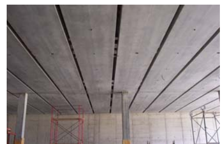
Untersicht Decke im Rohbau
