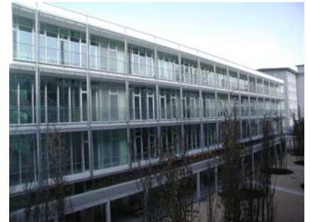
Ansicht Lauben und Umgangsdächer
