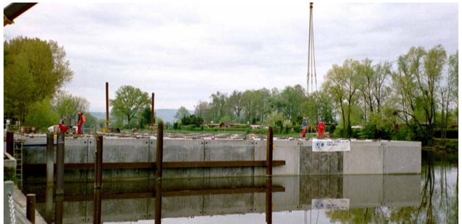
Zusammenbau der Betonwürfel zur schwimmenden Plattform im Broye-Kanal
