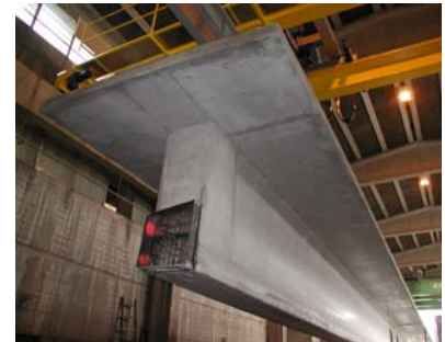
Frisch ausgeschalter Träger im Werk
