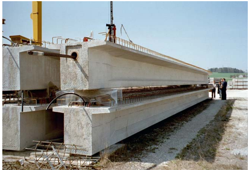
Träger auf dem Lagerplatz. Gut ersichtlich ist das eingelegte Vorspannkabel.
