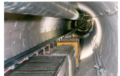
Tunnel im Bau
