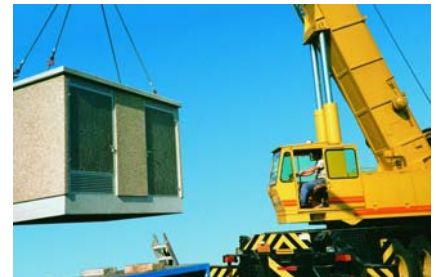
Montage einer Station mit Pneukran
