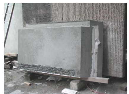
Fertige Sandwichplatte mit Anschlussbewehrung
