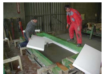
2. Einlegen der Wärmedämmschicht
