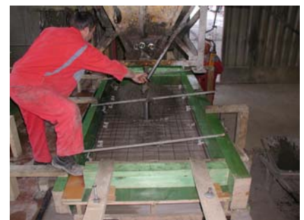
1. Einfüllen der Vorsatzschicht
