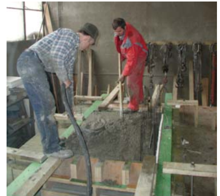
3. Auffüllen der Tragschicht
