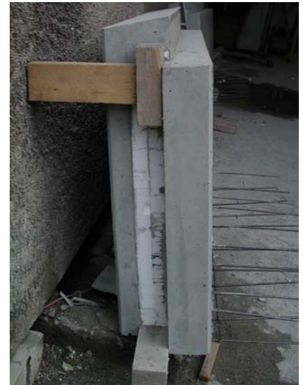
Aufbau der Sandwichplatte
