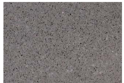
Beton eingefärbt schwarz Abgesäuert und hydrophobiert Zuschlagstoffe Basalt + Scorall
