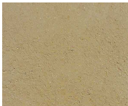
Gelb eingefärbter Beton
