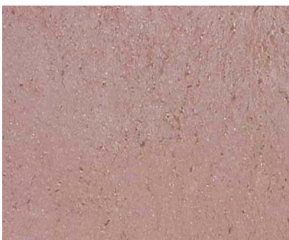
Rot eingefärbter Beton
