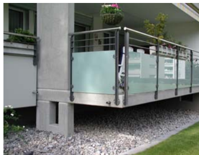
Entwässerung über Speier
