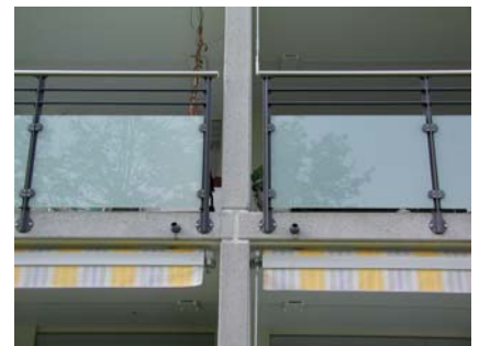
Befestigungen mit Klebeankern
