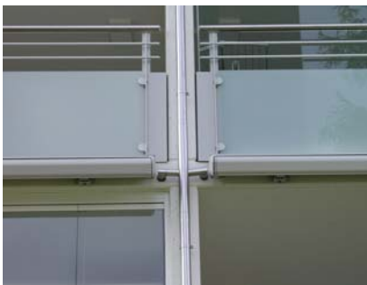
Entwässerung über Fallrohr
