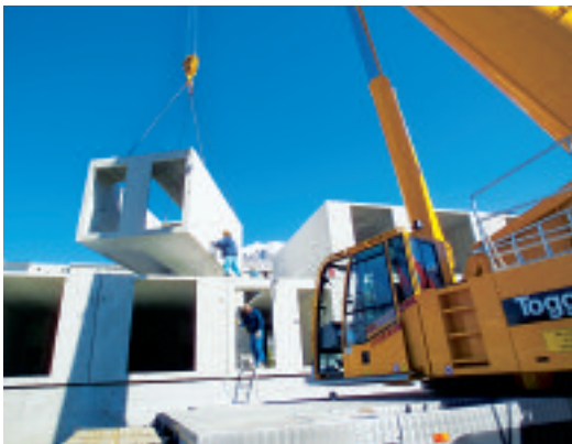
Oben: Los gehts: Verladung der vorgefertigten Hotelzimmer in Avenches.
